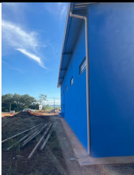
Fotografia 04: Calçamento externo Fonte: Próprio
