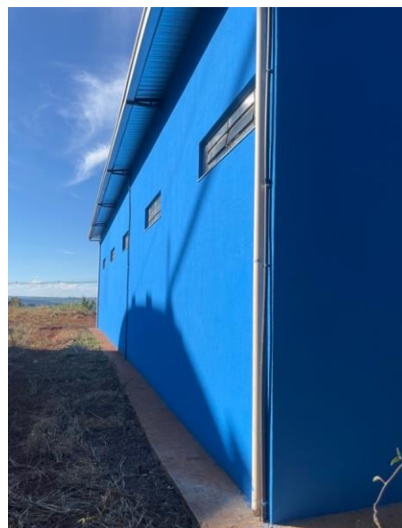
Fotografia 03: Calçamento externo Fonte: Próprio
