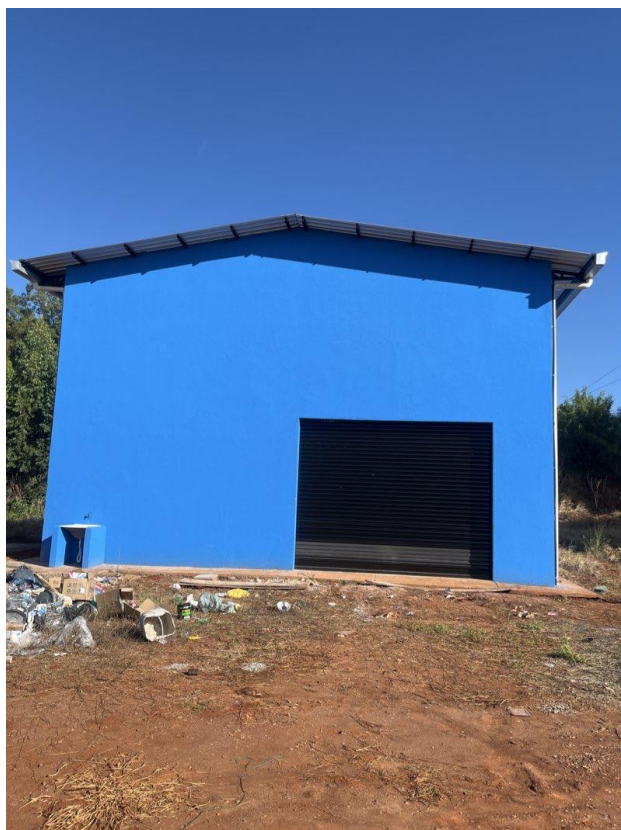
Fotografia 01: Vista frontal do barracão Fonte: captura própria
