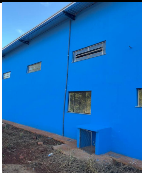
Fotografia 05: Calçamento externo Fonte: Próprio
