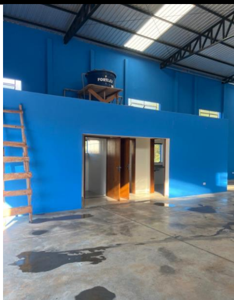
Fotografia 08: pátio do galpão Fonte: Próprio
