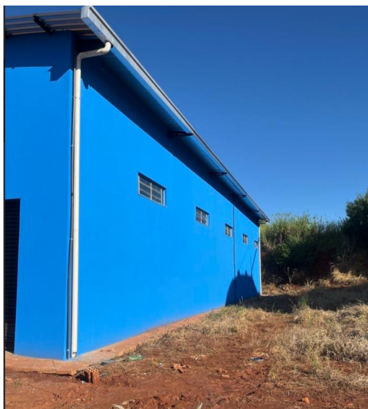
Fotografia 02: Calçamento externo Fonte: Próprio
