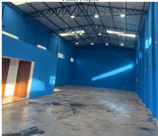
Fotografia 11: pátio do galpão Fonte: Próprio
