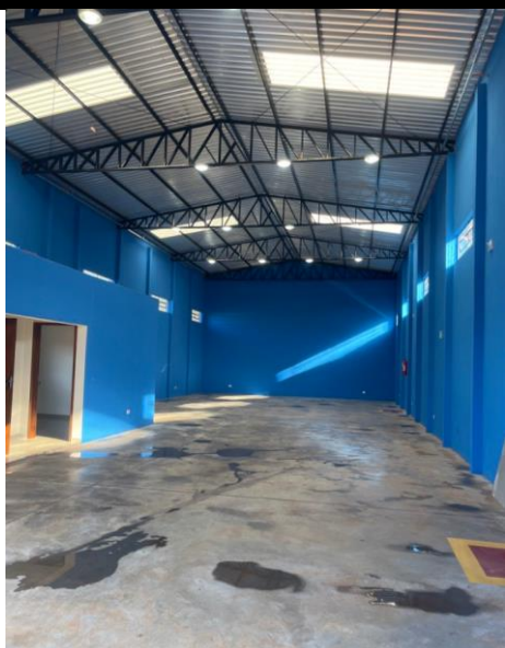
Fotografia 07: pátio do galpão Fonte: Próprio
