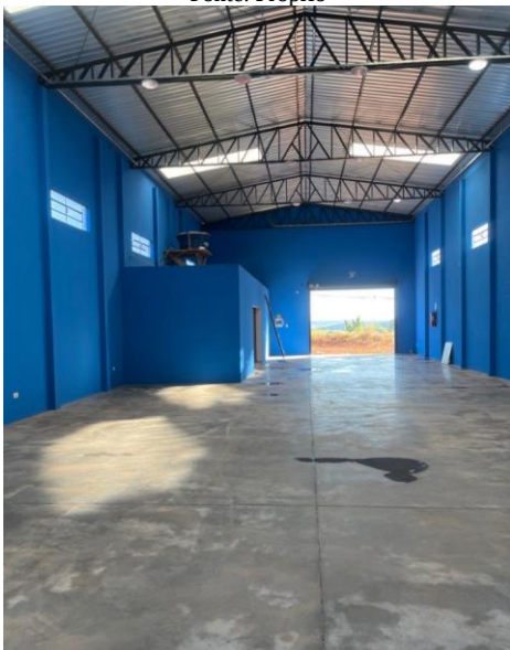
Fotografia 09: pátio do galpão Fonte: Próprio
